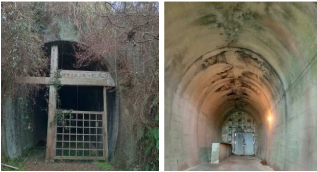
トンネルの入り口（左）とトンネル内部（右）
