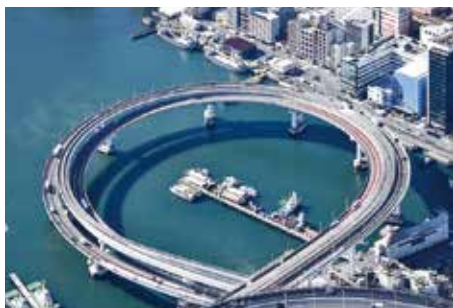
▲道路建設や整備
