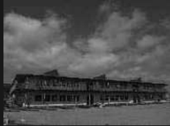
校舎 山元町立山下第二小学校
