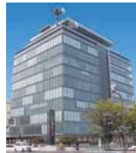
▲滋賀県警察本部（大津市） 総工費：約 186 億円 平成 21 年 1 月完成
