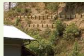
人家裏の急斜面に丸太柵工を施工して、斜面の崩壊を防止
