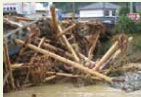
平成21年台風9号で発生した流木が下流の橋を損壊
