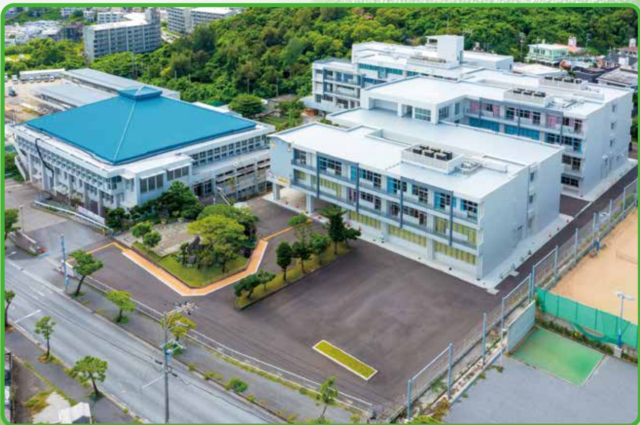
沖縄県立開邦高等学校 (写真提供: 沖縄県土木建築部)
