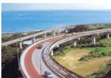
▲道路の建設や整備をしています。 南城市・ニライカナイ橋
