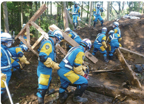
災害復旧の様子
