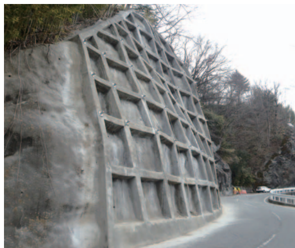
芝平高遠線 のりめん 法面補修工事後（伊那市）
