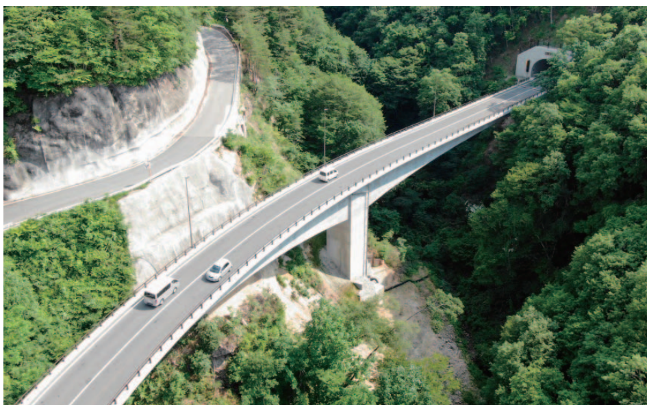
矢越トンネル・滝上大橋（筑北村）
