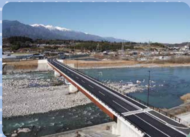
宮ヶ瀬橋（松川町）
