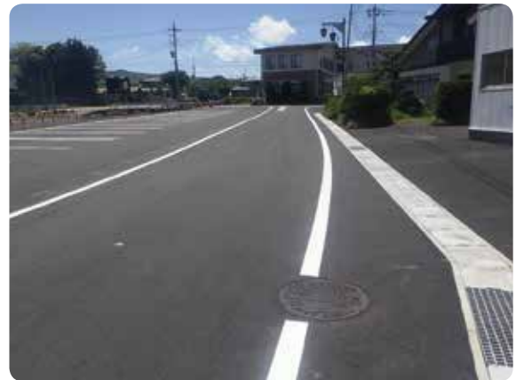
村道改良工事(孺恋村)
