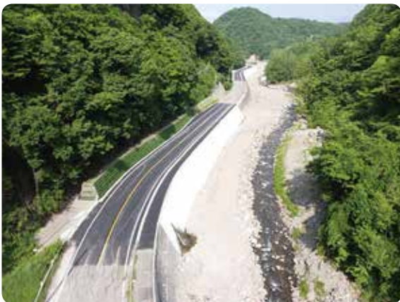
令和元年東日本台風災害復旧(国道144号)
