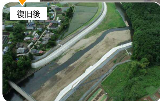
令和元年東日本台風による災害復旧事業(那須烏山市)
