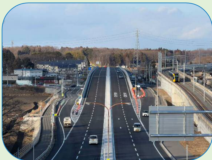
一般国道408号宇都宮高根沢バイパス野高谷立体
