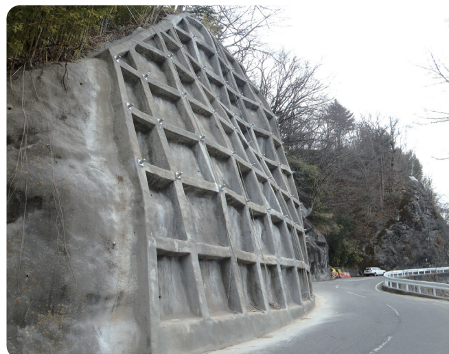
芝平高遠線 法面補修工事後（伊那市）
