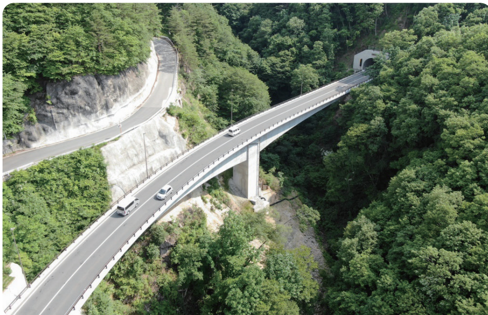
矢越トンネル・滝上大橋 (筑北村)
