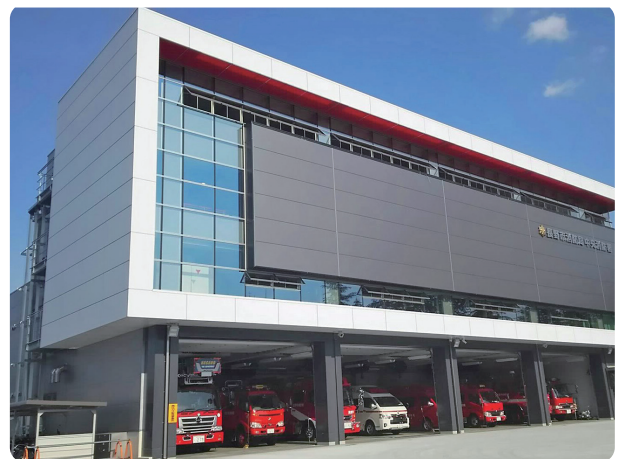
長野市消防局中央消防署 (長野市)
