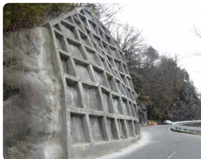
芝平高遠線 法面補修工事後（伊那市）
