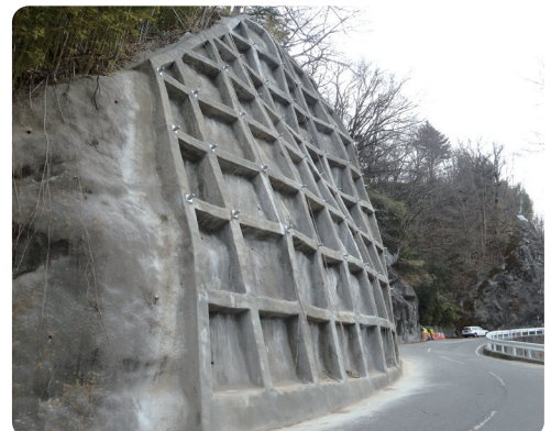
芝平高遠線 法面補修工事後（伊那市）
