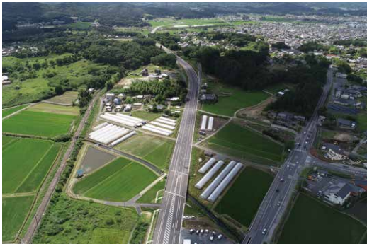
国道355号 笠間バイパス(笠間市) 令和元年6月開通 (提供:茨城県水戸土木事務所)
