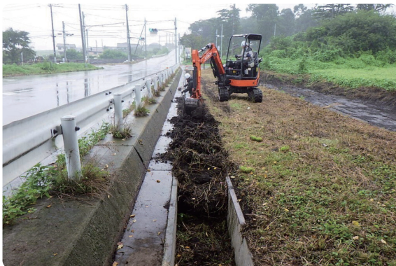
村道維持補修工事2 (昭和村)
