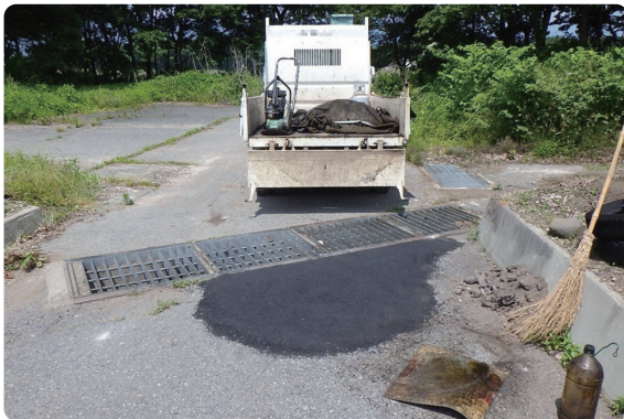
村道維持補修工事1 (昭和村)
