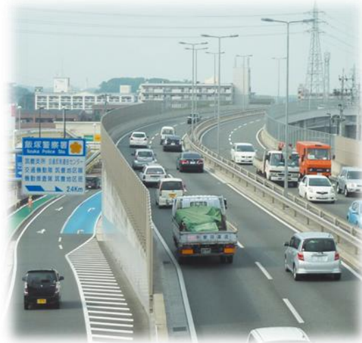
橋や道路の整備
