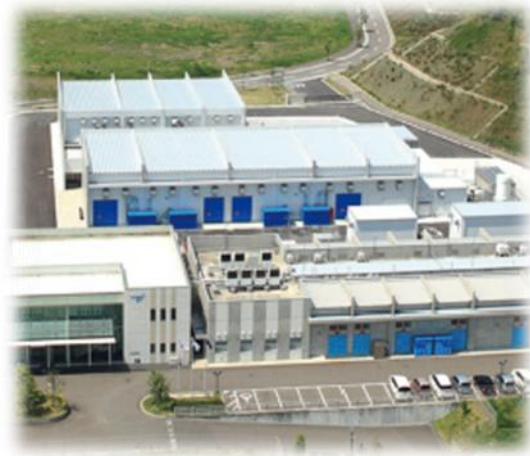
水素エネルギー製品研究試験センター
