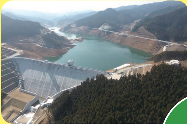
伊良原ダム（みやこ町）
