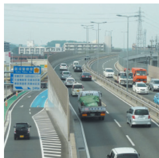
橋や道路の整備
