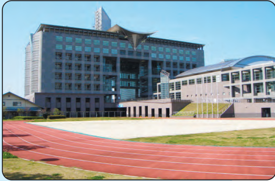
クローバープラザ（春日市） 工事費約159億円
