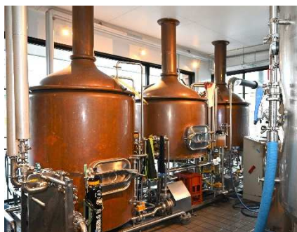
TDM 1874 BREWERY 内のビールタンク
