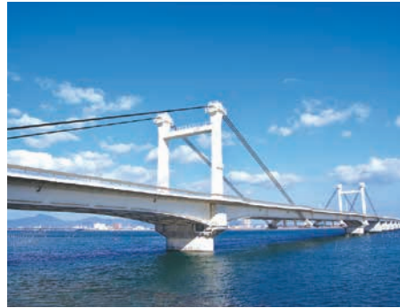
交通渋滞 じゅうたい をなくすための橋 (阿波しらさぎ大橋) 建設費用約300億円
