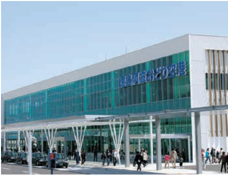
徳島の空の玄関 (徳島阿波おどり空港) 建設費用約470億円
