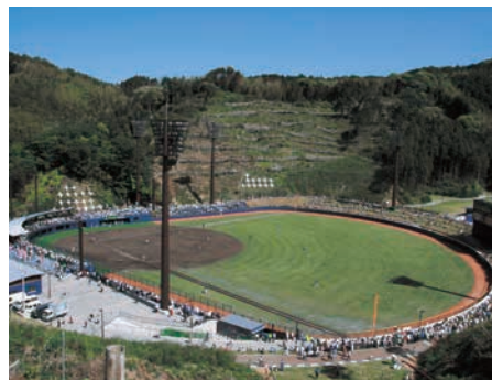
スポーツ施設 しせつ を造っています。 (JAアグリあなんスタジアム) 建設費用約13億円
