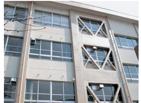
地震から学校を守ります。(耐震工事)
