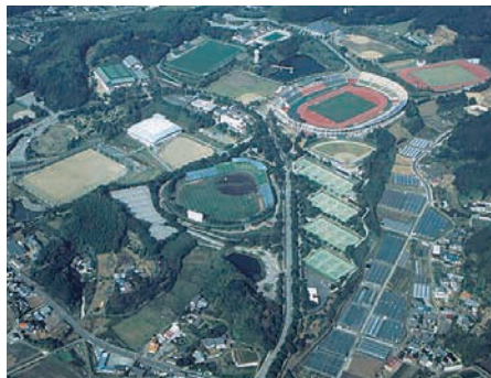
スポーツ施設を造っています。 (春野総合運動公園)
