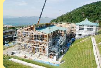
鳥羽市立神島中学校(建設中) 誰もが平等に教育を受けるために
