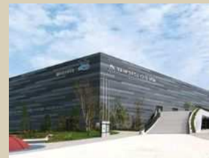
福岡市総合体育館
