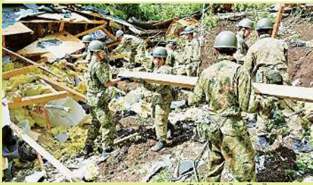
▲陸上自衛隊による災害復旧 写真提供 防衛省ホームページ
