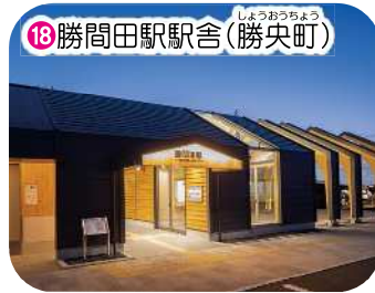
18 勝間田駅駅舎(勝央町) 総工費：1億3000万円
