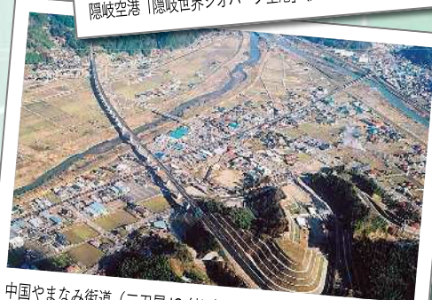
中国やまなみ街道 (三刀屋 IC 付近) (雲南市) 総工費：約 191 億円
